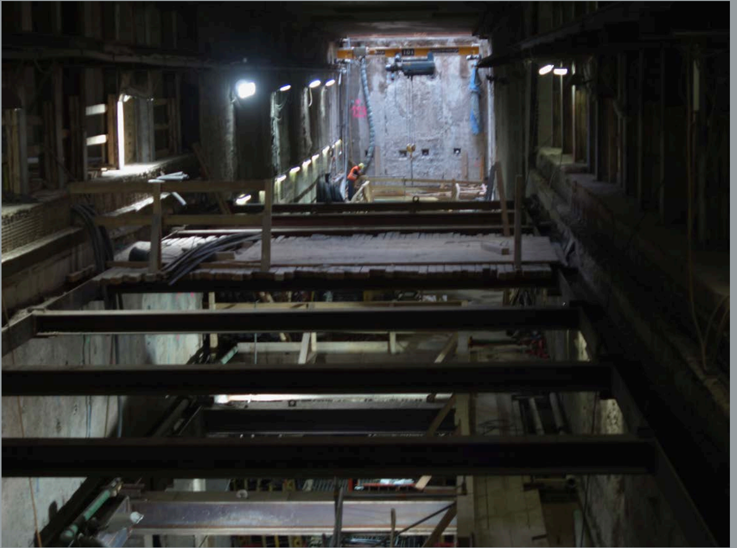
U-Bahn-Bau Köln, 2008, Foto auf Alu-Dibond, 100×75 cm;
